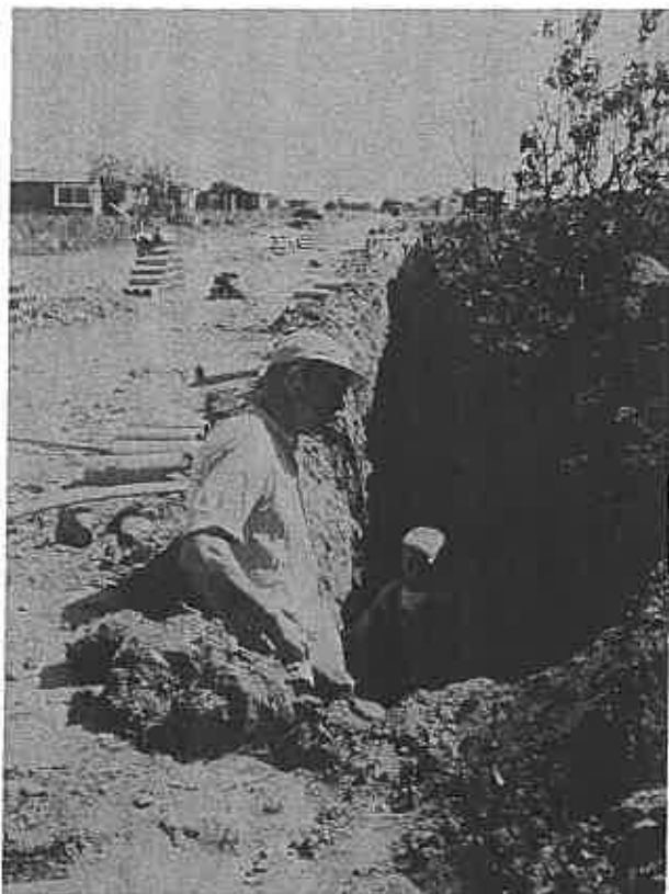
Nedlægning af drænrør
